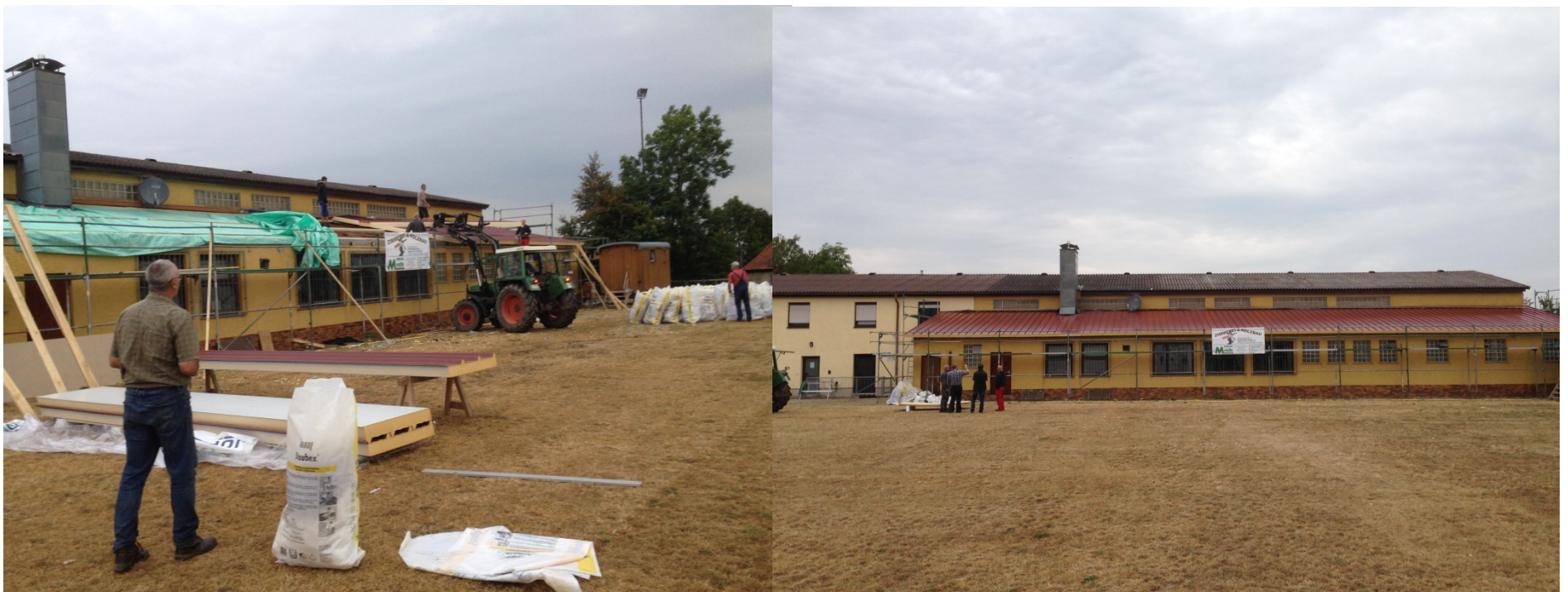
(Montage der Dachpaneele am 16.9.2016)
